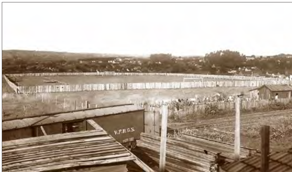
Vista completa do Estádio da Montanha já cercado. Detalhe para a proximidade com a rede férrea
